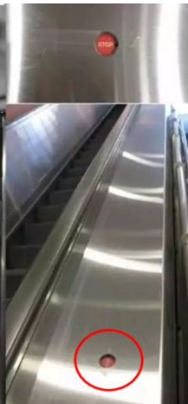
大型电梯中部
