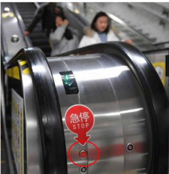
电梯内侧盖板底部
