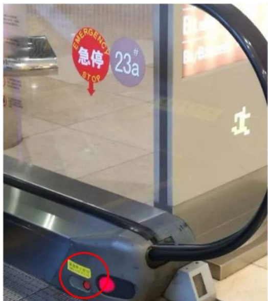
电梯入口扶手处
