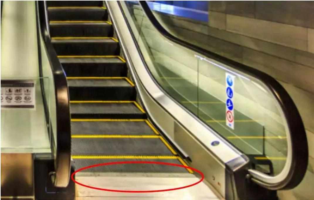
**当梳齿与梯级的间隙增大或是部分梳齿断裂时，会形成相对较大的间隙，如果小孩子的手或是脚被卡进去的话，将会造成夹伤甚至夹断的事故。**
